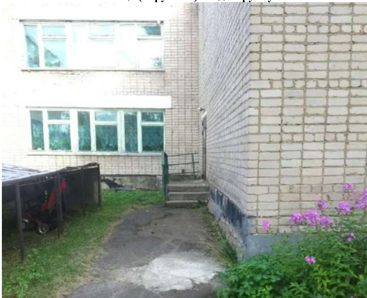
Лестница (наружная) вход в группу 03
